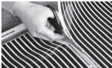
Рис. 4. Разрезание термопленки CALEO по линиям отреза
